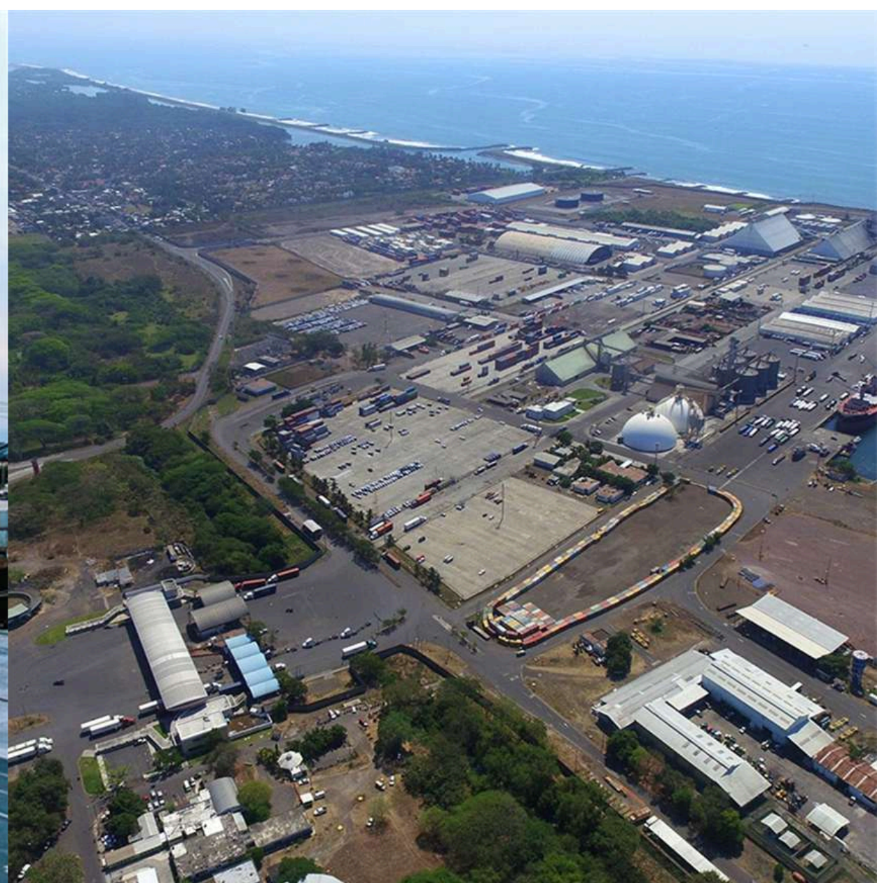
CARGA CONTENERIZADA EPQ: 40%
